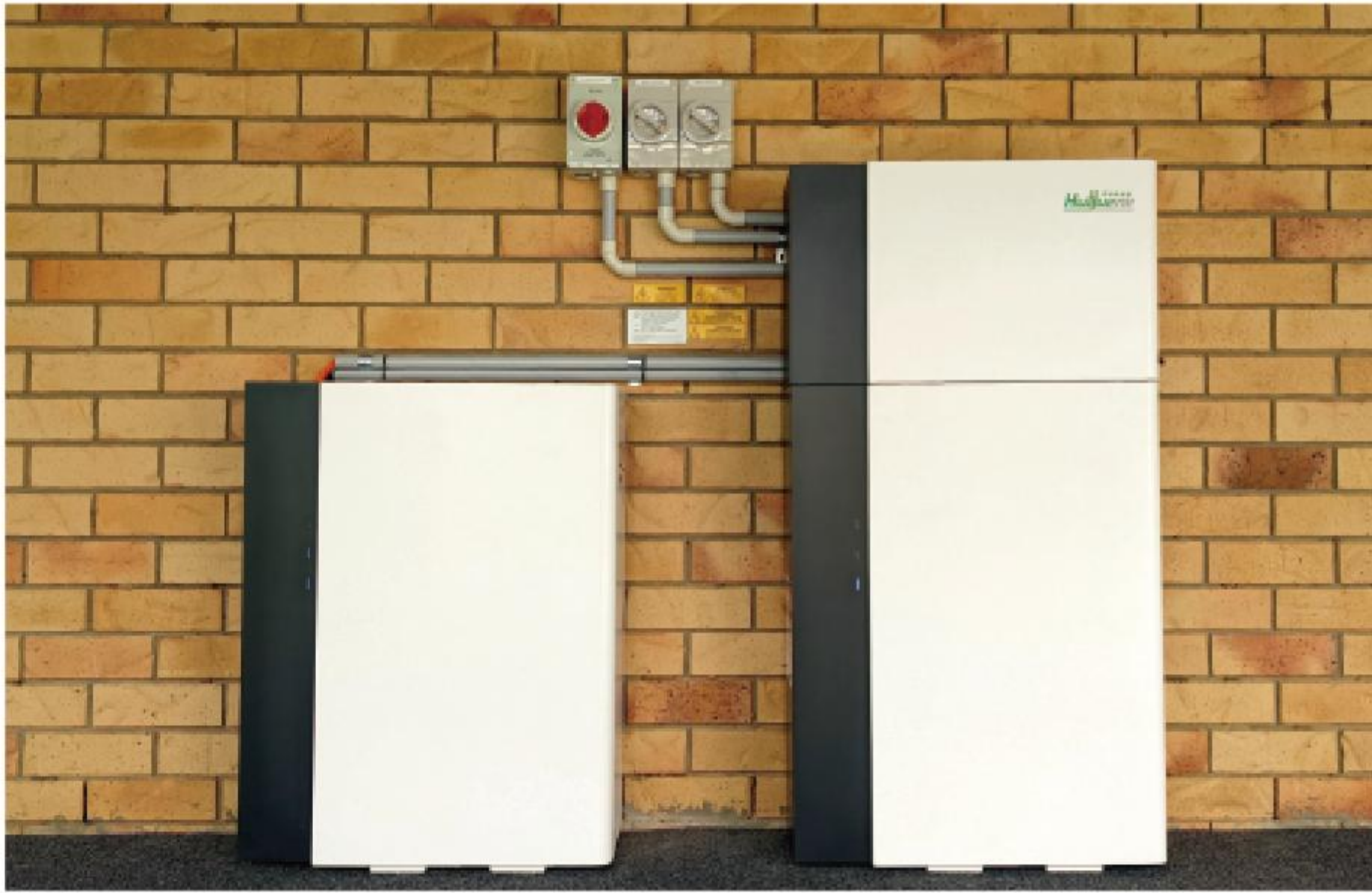
英国 7kW/15KWh家用储能系统
