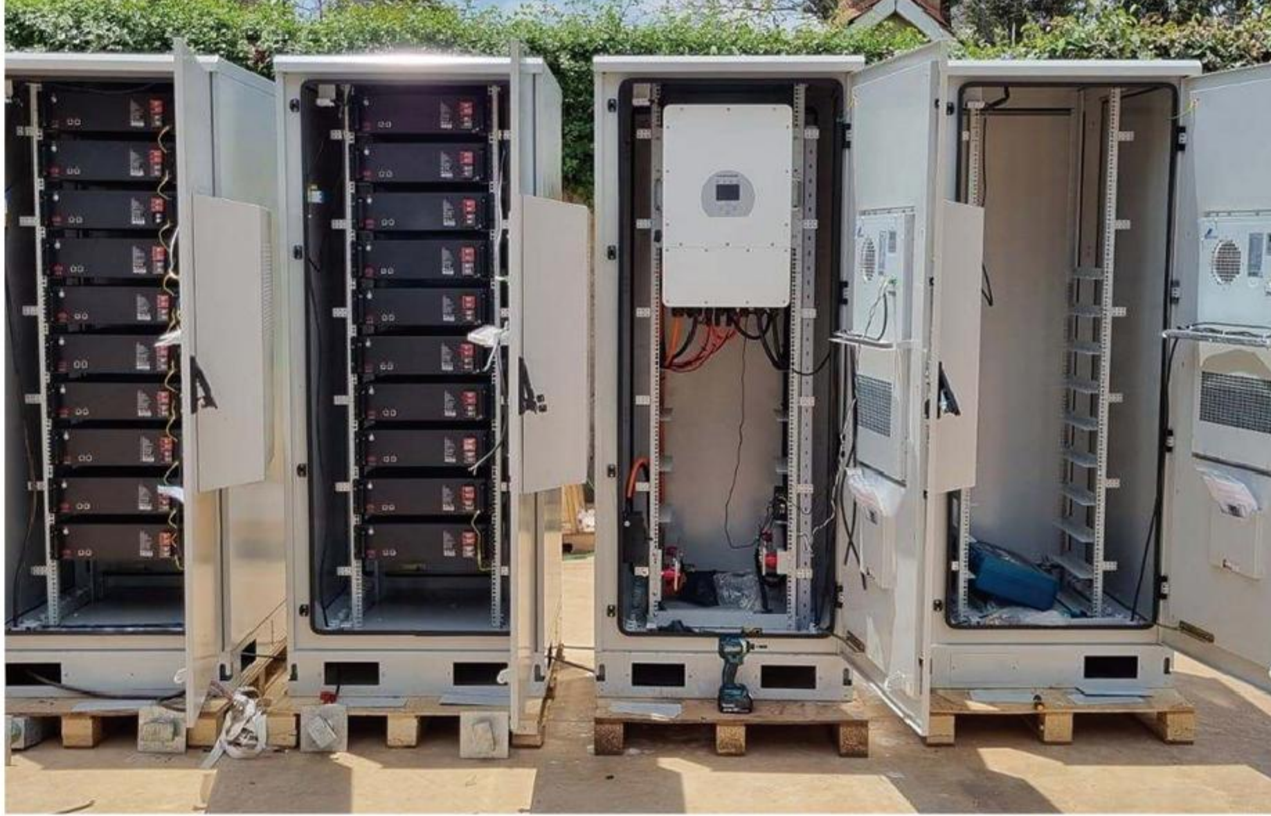
肯尼亚50KWh并机的室外储能系统
